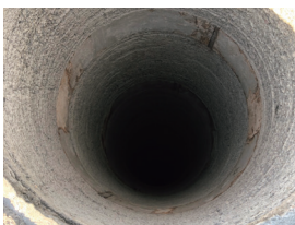
既存ライニング材撤去
