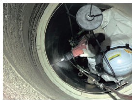
ライニング材直貼り
